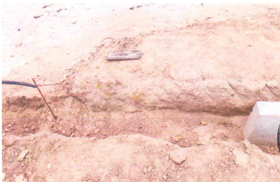
FOTO 02 – ESCAVAÇÃO MANUAL DE VALA COM PROFUNDIDADE MENOR OU IGUAL A 1,30 M
