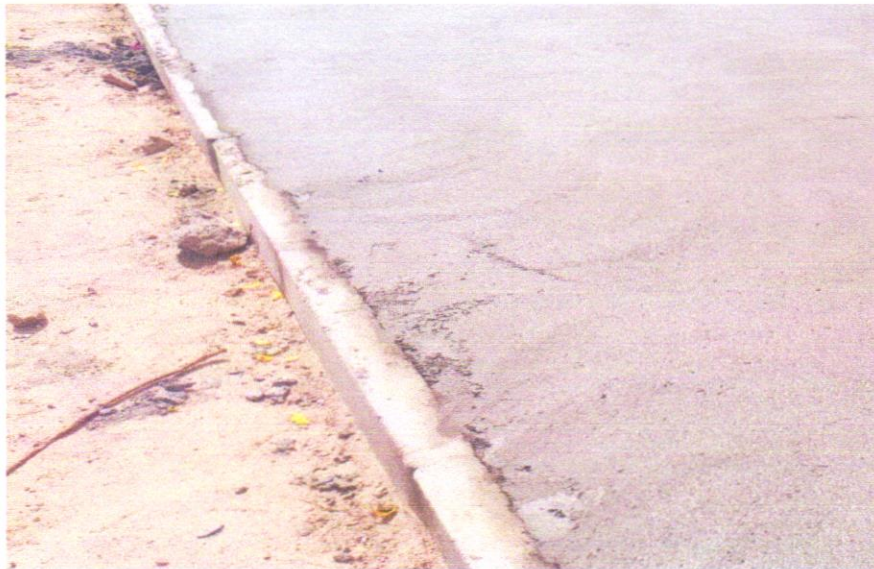
FOTO 07 – PAVIMENTAÇÃO EM CONCRETO, COM ESPESSURA DE 7 CM, COM ACABAMENTO FEITO UTILIZANDO ALISADORA DE CONCRETO (HELICOPTERO), INCLUIDO TELA DE AÇO SOLDADA NERVURADA CA60, Q196 (3,11 KG/M 2 ), DIÂMETRO DO FIO 5.0 MM, LARGURA = 2,45 M, ESPAÇAMENTO DA MALHA = 10 X 10 CM, JUNTA DE DILATAÇÃO EM PVC A CADA 2,00 M, CONCRETO FCK = 20 MPA
