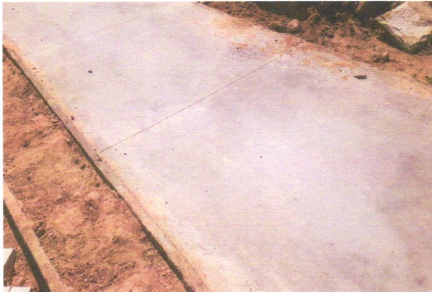
FOTO 07 – PISO EM CONCRETO FCK = 20 MPA, PREPARO MECÂNICO, ESPESSURA 7 CM, COM ARMAÇÃO EM TELA SOLDADA
