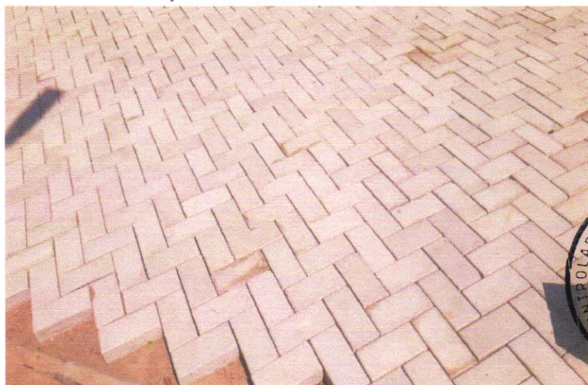
FOTO 08 – PAVIMENTAÇÃO EM BLOCO DE CONCRETO VIBROPRESADO, INTERTRAVADO, COR NATURAL, 10X20CM, E=6CM, 46UN/M 2 , NBR9781, FCK(MIN)=35MPA, SOB COXIM AREIA GROSSA COMPACTADA C/ PLACA VIBRATÓRIA, E(COMP.)=6CM, REJUNTADO C/ AREIA FINA.
