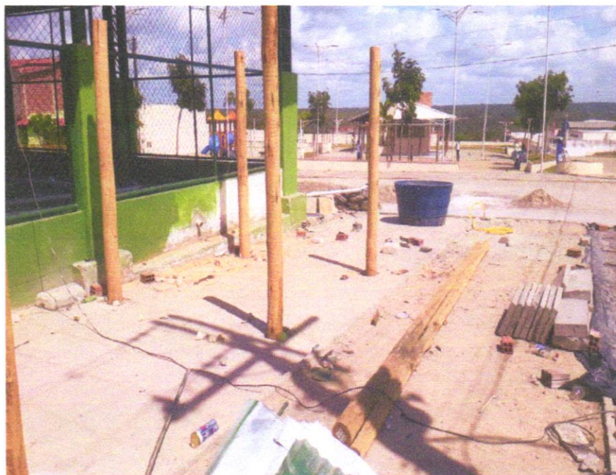
FOTO 08 – FORNECIMENTO DE PEÇA DE EUCALIPTO TRATADO, D= 19 A 22CM, L= 4,00 M (MOURÕES).
