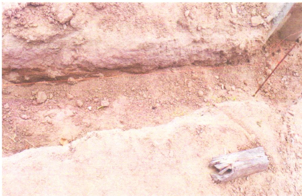
FOTO 01 – ESCAVAÇÃO MANUAL DE VALA COM PROFUNDIDADE MENOR OU IGUAL A 1,30 M
