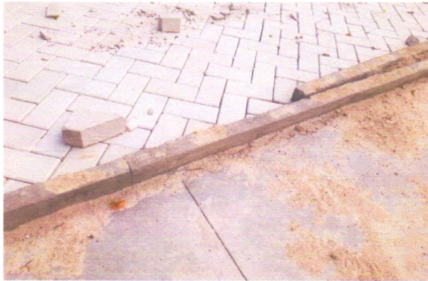
FOTO 05 – ASSENTAMENTO DE GUIA (MEIO-FIO) EM TRECHO RETO, CONFECCIONADA EM CONCRETO PRÉ-FABRICADO, DIMENSÕES 80X08X08X25 CM (COMPRIMENTO X BASE INFERIOR X BASE SUPERIOR X ALTURA), PARA URBANIZAÇÃO INTERNA DE EMPREENDIMENTOS. AF_06/2016
