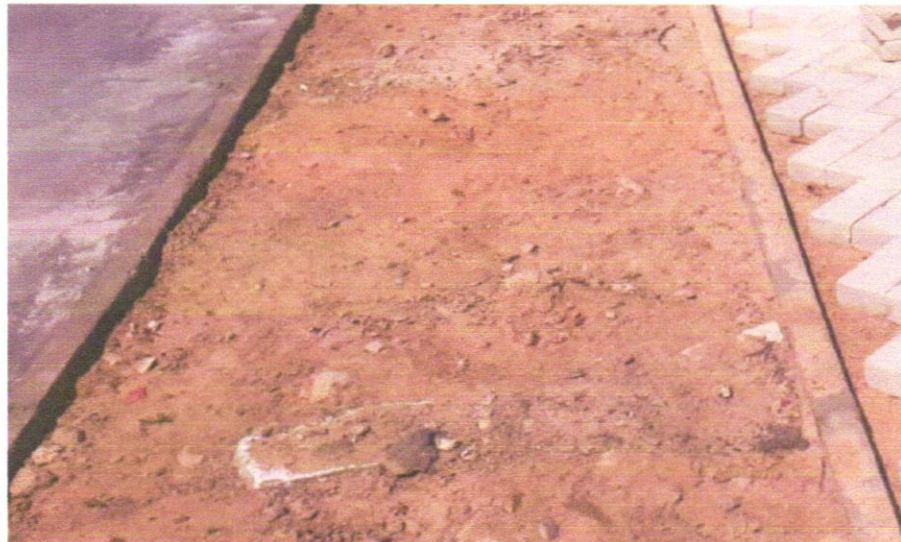
FOTO 03 - REATERRO MANUAL COM COMPACTAÇÃO MECANIZADA EM CAMADAS DE 0,20 M NO MÁXIMO, COM MATERIAL DA PRÓPRIA OBRA
